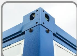
Izaje en grúa portacontenedores
